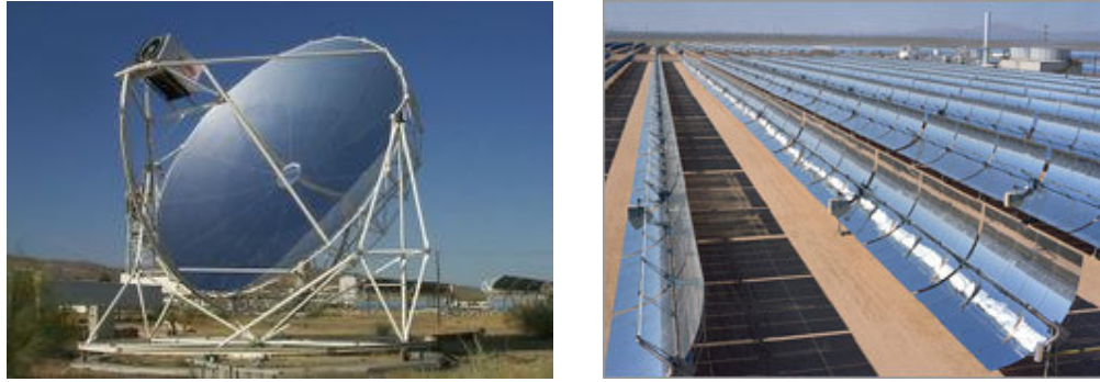
Figs. 3.1 e 3.2 – Concentradores pontual (esquerda) e linear (direita) (SolarPaces)
